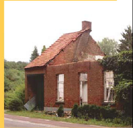
Langs de Heide in Westmeerbeek getuigt deze woning van het huidige beleid: de brandweer kan niet op tijd komen.
